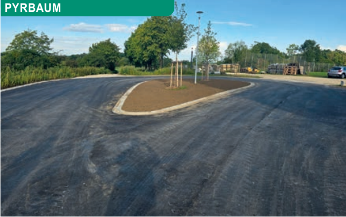
Arbeiten im Außenbereich der Schule
