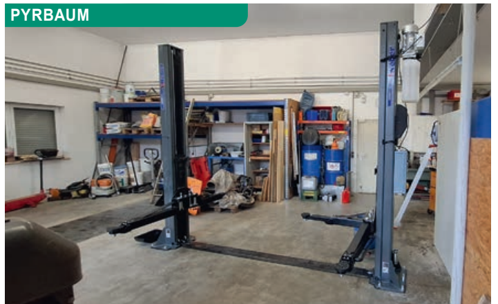
Bauhof: Neue Hebebühne für die Werkstatt errichtet
