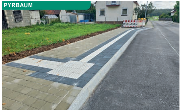
Bushaltestelle Waldstraße wurde verlegt
