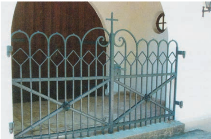
Das Gitter des „Leichenhauses“ in Pyrbaum, 1948 von Schmiedemeister Hans Rüd angefertigt
